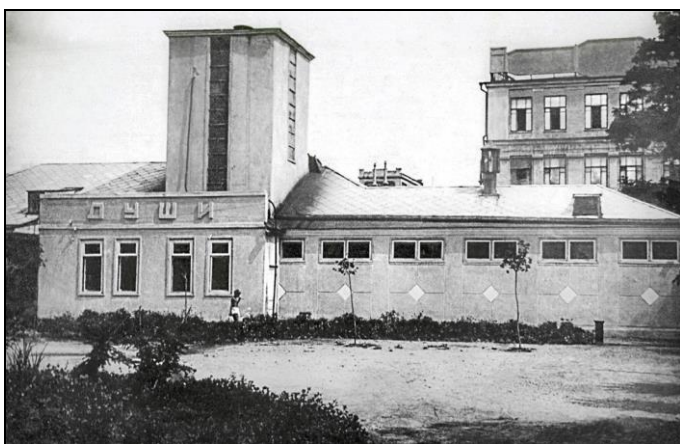
Рис. 16. Здание душевых в парке им. М. Горького. 1940 г. (ГАРО. Коллекция фотодокументов. Инв. № О-17015)
